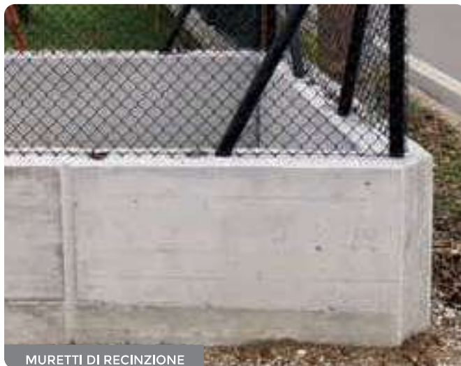
MURETTI DI RECINZIONE
