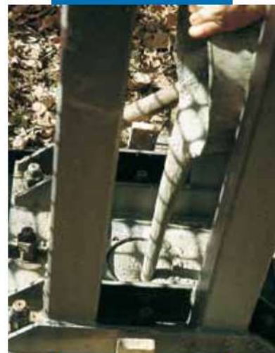
Inghisaggio con Mapefill
