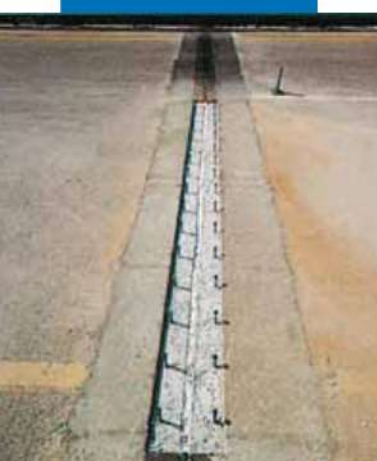
Ripristino di giunto di ponte autostradale con Mapefill
