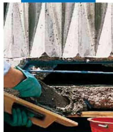
Esempio di riparazione di un balcone con Mapegrout T40
