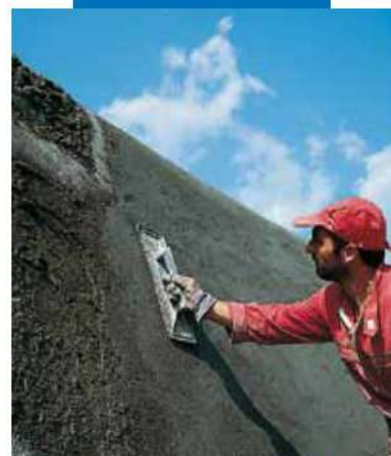
Rifinitura del Mapegrout T40 a frattazzo
