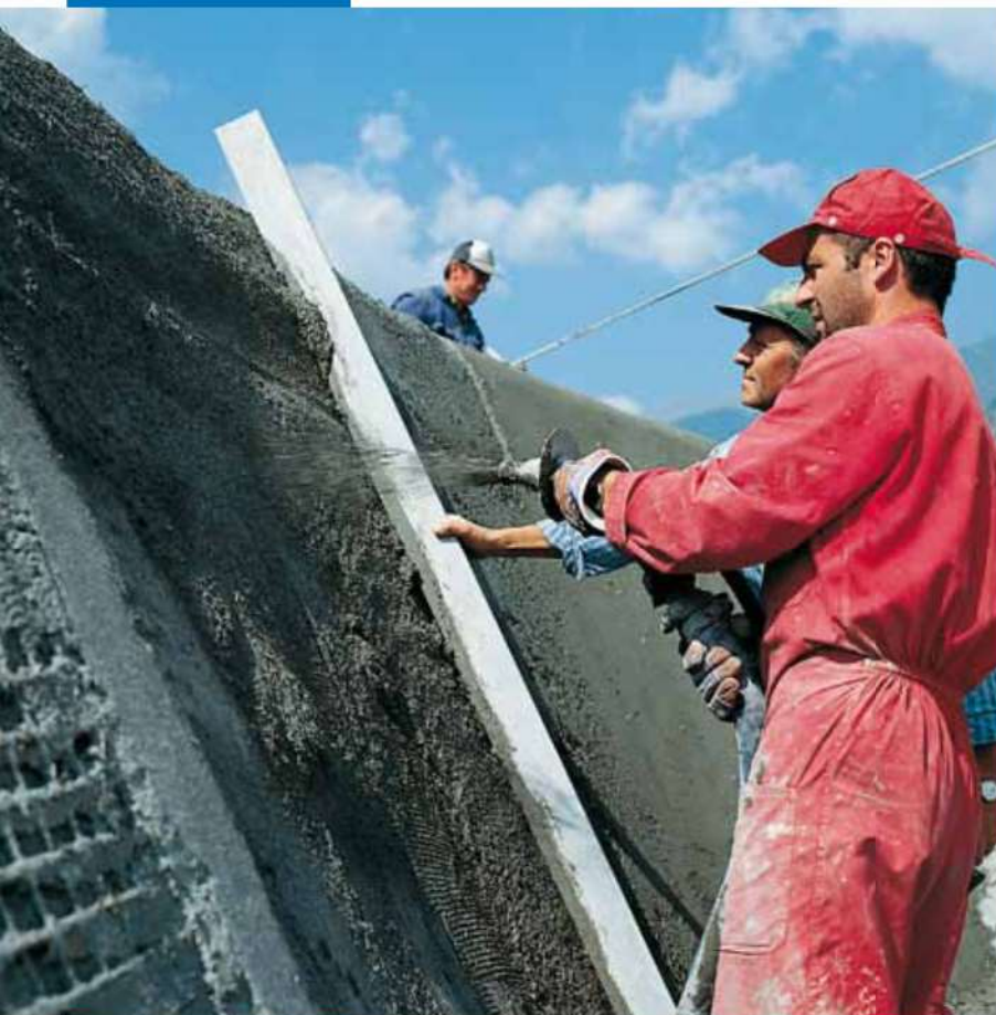
Applicazione di Mapegrout T40 con macchina intonacatrice
